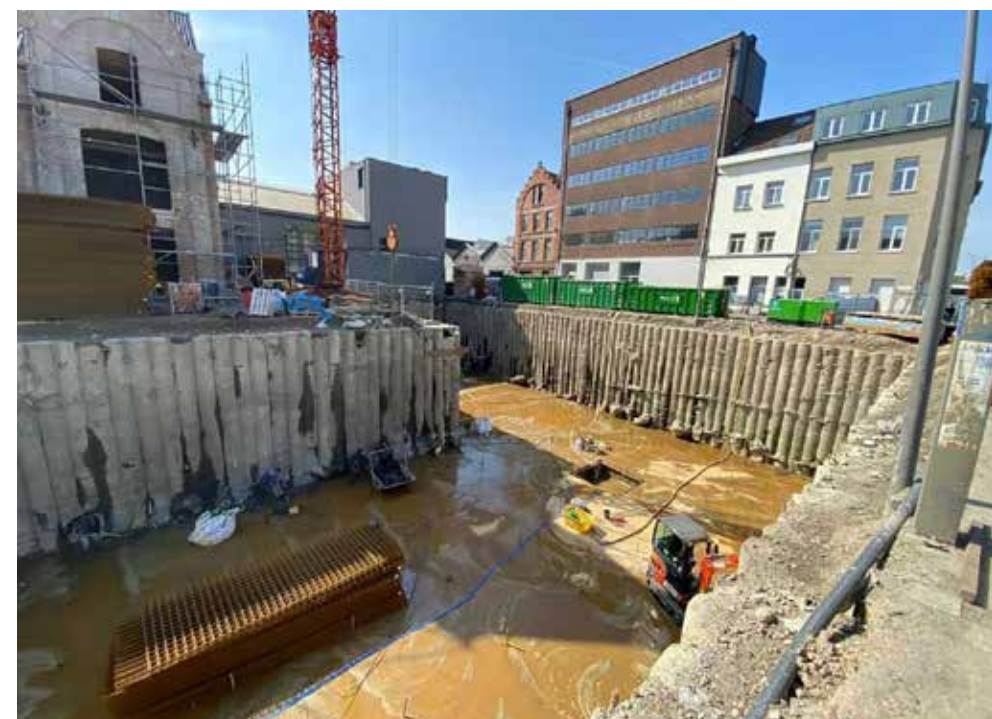
Het uitvoeringsontwerp, voor de diepfundeerder Van Rooy, van een verankerde onderwaterbetonvloer alsook de uitwerking van een conceptuele oplossing voor het funderen van het appartementsgebouw.
